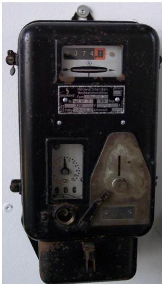
Abbildung 39: Kassierstromzähler mit Münzeinwurf; Quelle: Stahlkocher
